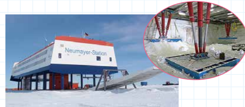
ノイマイヤーIII基地/ドイツ 長さ68m、幅24m、床の高さ6mの巨大な建物。地下室に雪上車や油圧ジャッキを格納。床下に雪がたまると、油圧ジャッキで雪を押し固め、建物全体を持ち上げる。
