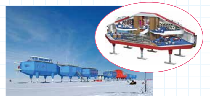
ハレーVI基地/イギリス 平らな棚氷の上につながる8台のユニット。青は宿泊施設や研究棟、赤は食堂や談話室。スキーの支柱が伸び縮みして、自由に移動できる。
