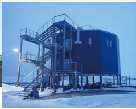
昭和基地・基本観測棟/日本 十二角形をした2階建ての建物で、2018年完成予定。雪が積もらないように高床になっている。完成後は、これまで別棟で行われていた気象、電離層、地学、環境科学の観測がここに集まる。
