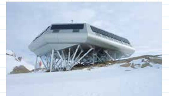
プリンセス・エリザベス基地/ベルギー 南極では初めて「温室効果ガス排出ゼロ」を達成した基地。層になったステンレスなどの壁で太陽熱を受けて暖房し、9基の風力発電機で電気をつくる。
