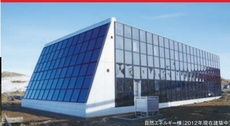
自然エネルギー棟（2012年現在建築中）
